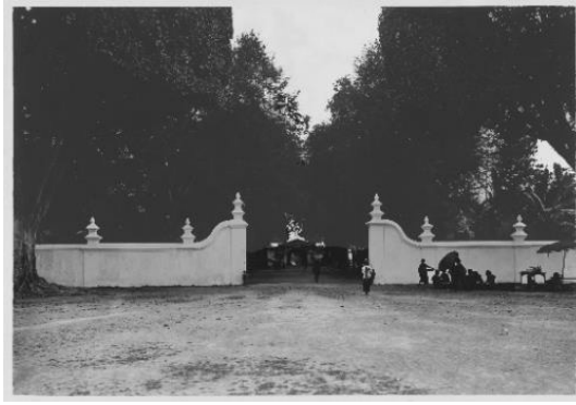
Fig 43. Street on the north of Plengkung Nirbaya then Source : (De Zuidelijke Uitgang van de Aloen-Aloen Te Jogjakarta | Digital Collections, 1900)
